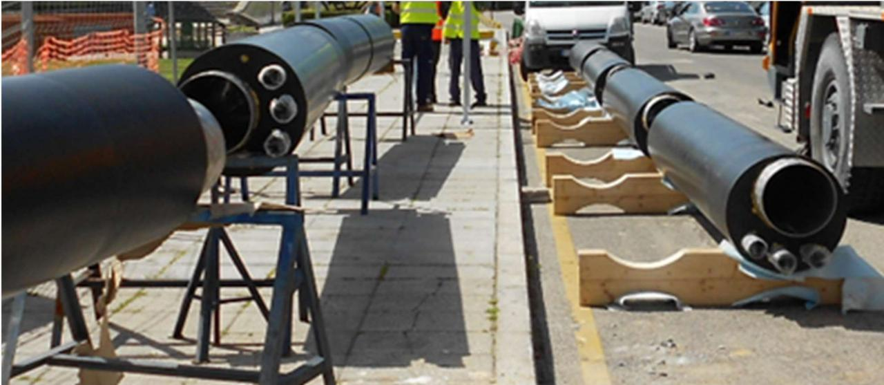
Abb. 14 Foto einer Baustelle zum Einbau von Doppelrohrwärmetauschern
