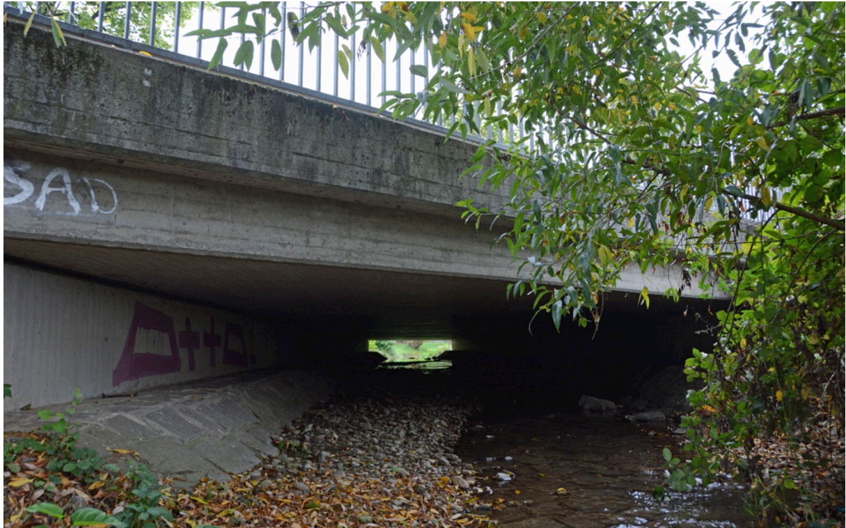
Abbildung 19: Bisheriger Dietenbachdurchlass unter der Besançonallee, der aufgeweitet werden könnte.
