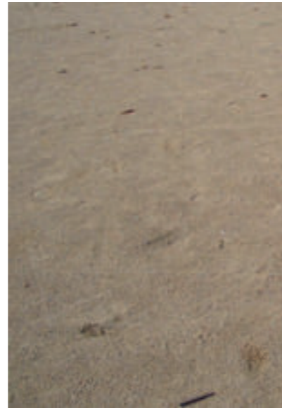
Wassergebundene Wegedecke für untergeordnete Fußwege
