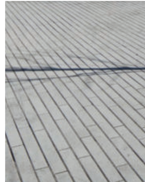
Betonpflaster für neue Gehwege
